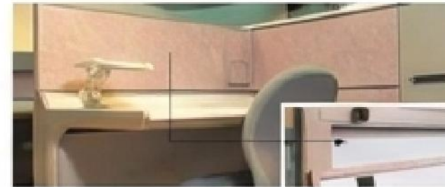
ローバーテーションの取り付け
